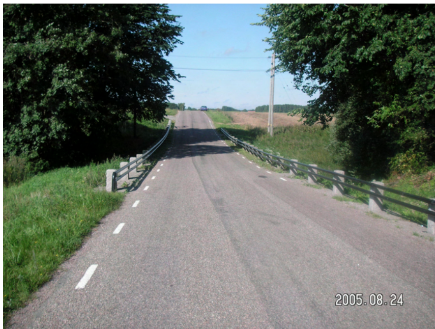
Figur 8.8 Bro C187. Nytt räcke på stenstolpar.
