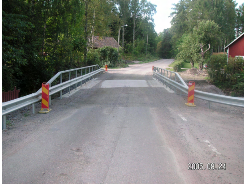
Figur 8.3 Bro C185. Ny överbyggnad.
