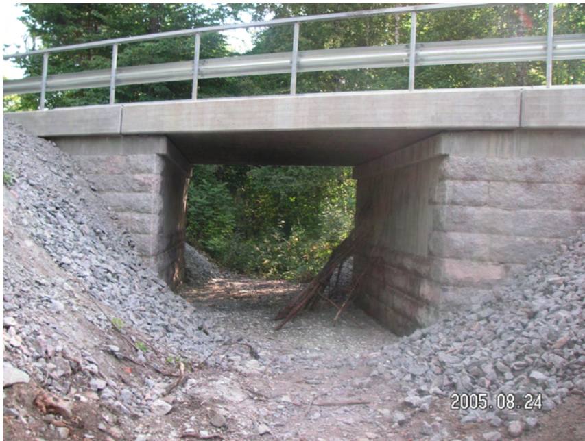
Figur 8.4 Bro C185. Ny överbyggnad på befintliga landfästen.
