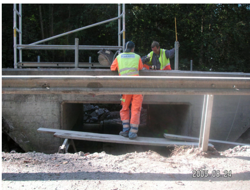
Figur 8.10 Bro C648. Ny överbyggnad, täcksiktetsökning på betong och nya landfästen samt bärighets- höjande åtgärder från BK2 till BK1.
