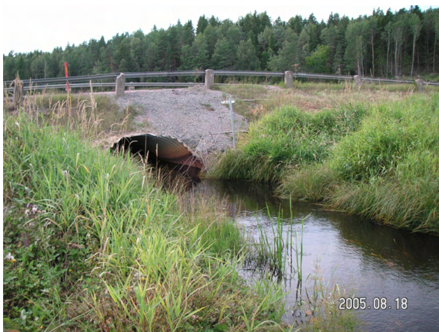
Figur 8.13 Bro C679. Det skedde ett brott på den högra sidan av rörbron.
