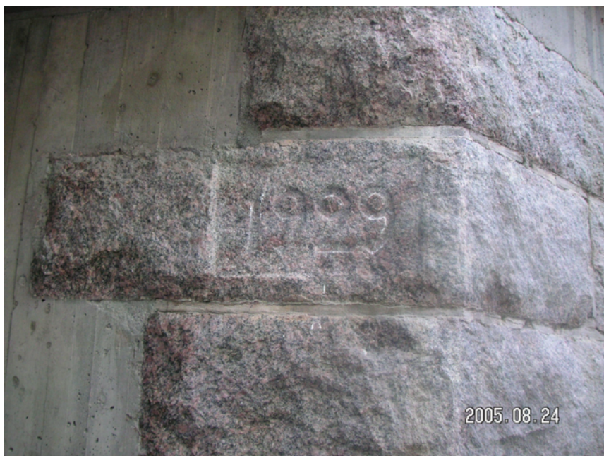
Figur 8.5 Bro C185. Befintliga landfästen från 1929.
