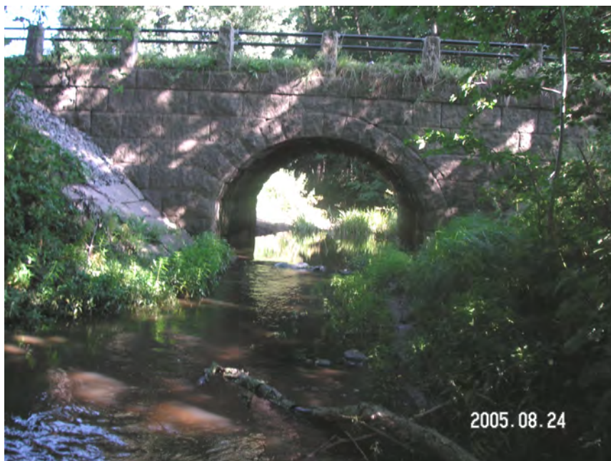
Figur 8.9 Bro C187. Nytt räcke på stenstolpar passar bra till den gamla stenbron.
