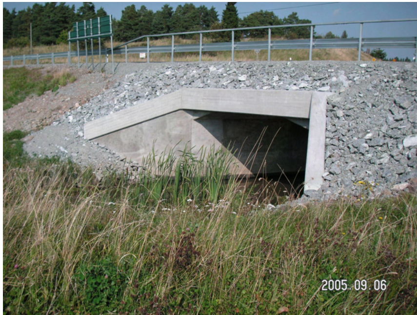
Figur 8.7 Bro C497. Utbyte kantbalkar, täcksiktökning på betong och nya landfästen.
