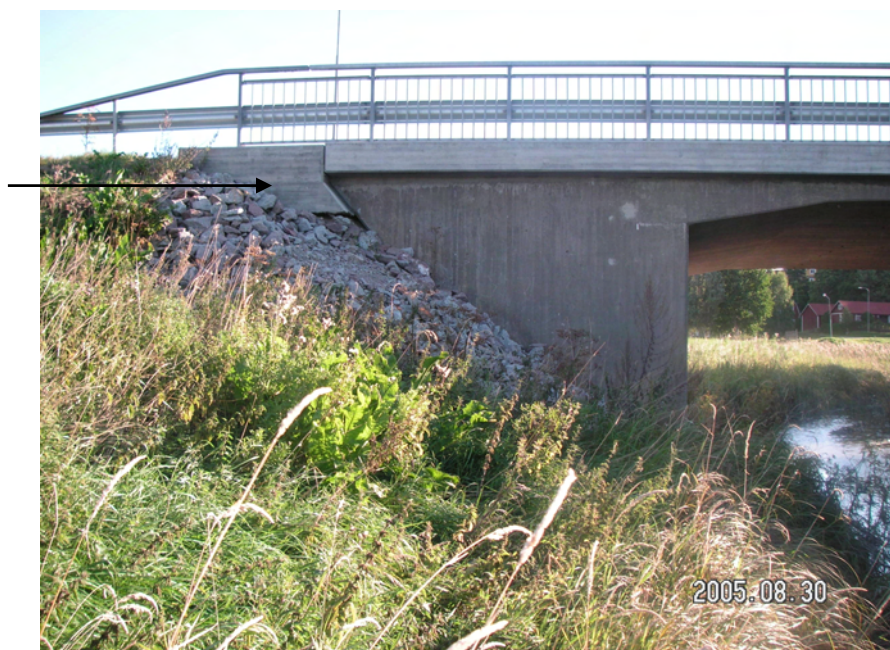
Figur 8.16 Bro C57. Monterat L-stöd mot befintliga kantbalkar, se pil.
