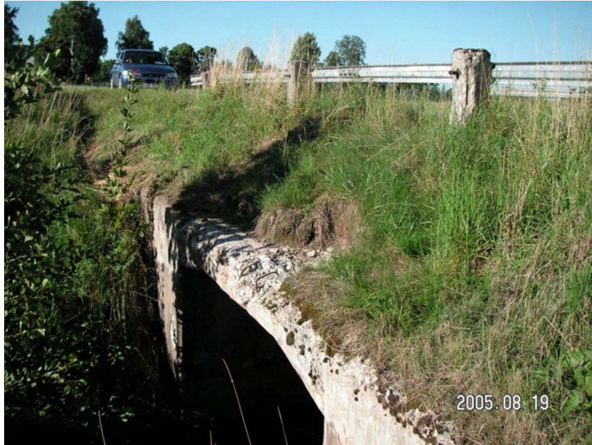
Figur 8.14 Bro C660. Betongen i kantbalken var i sämre skick än man hade trott.
