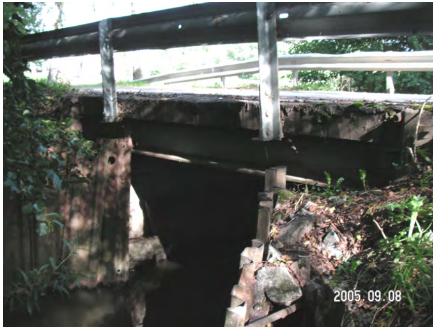
Figur 8.11 Bro C667. Hur bron såg ut innan den fick en ny överbyggnad.
