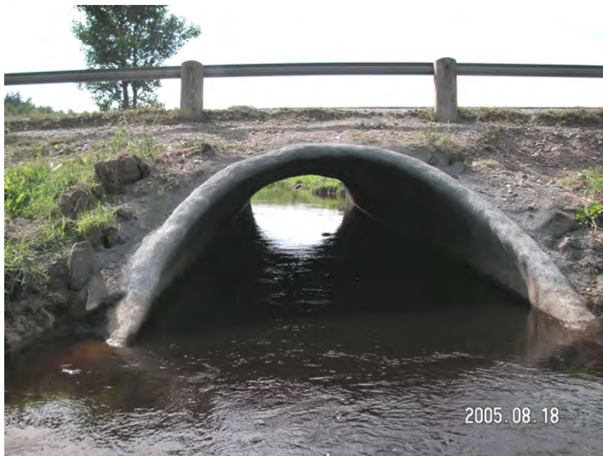
Figur 8.12 Bro C677. Rörbro som blev betongsprutad invändigt.
